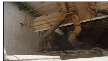
Figuras 79 e 80. Os 6 GMBs menores que formam os conjuntos Emissário I e II. Fonte: MJ Engenharia.
