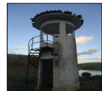
Figuras 148 e 149. Vegetação sobre a câmara de chegada e estrutura da ETE comprometida. Fonte: MJ Engenharia
