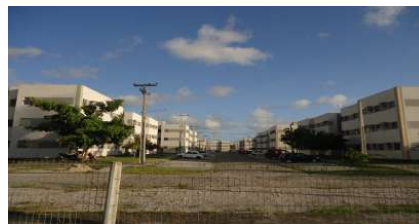
Figura 153. Condomínio Village das Artes. Fonte: MJ Engenharia
