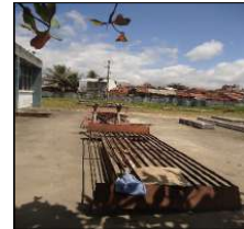
Figuras 76 e 77. Unidades de Gradeamento da ETE – Disposição Oceânica e detalhe para Gradeamentos não instalados. Fonte: MJ Engenharia
