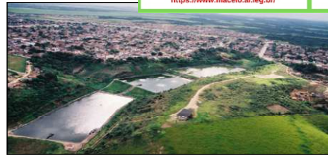
Figura 144. Vista aérea do sistema de tratamento por lagoas de estabilização de Benedito Bentes. Fonte: Maceió, IBAM, 2005
