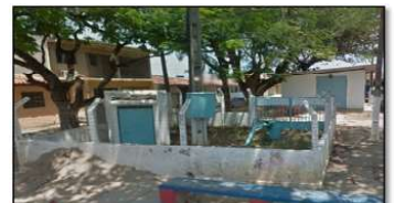
Figura 50. Poço de captação da CASAL
