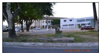
Figura 41. Poço de captação da CASAL
