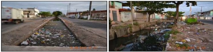
Figuras 140 e 141. Corpo hídrico completamente comprometido no bairro Levada. Fonte: MJ Engenharia
