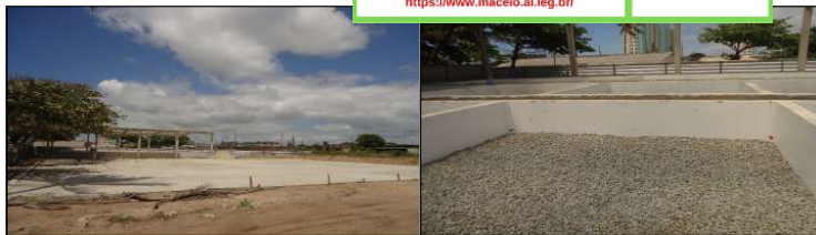
Figuras 87 e 88. Leitões de Secagem em Construção. Fonte: MJ Engenharia
