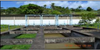
Figura 51. Entrada da captação. Fonte: MJ Engenharia
