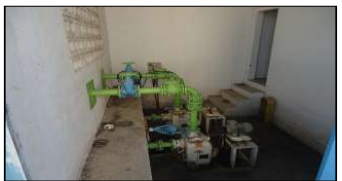
Figuras 158 e 159. GMBs das ETEs Recanto das Estrelas e Village das Artes. Fonte: MJ Engenharia
