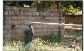
Figura 46. Poço de captação da CASAL
