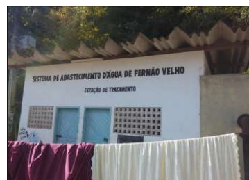
Figura 67. Casa de máquinas da ETA Fernão Velho. Fonte: MJ Engenharia.
