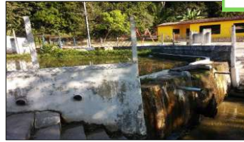
Figura 55. Barragem do Riacho Aviação. Fonte: MJ Engenharia
