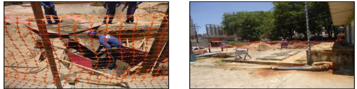
Figuras 101 e 102. Obras da Linha Expressa da Praça Lions. Fonte: MJ Engenharia
