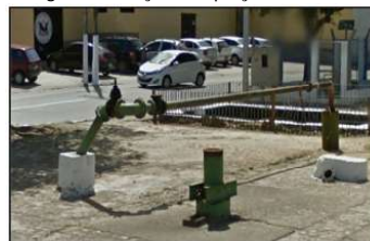
Figura 47. Poço de captação da CASAL
