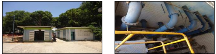
Figuras 99 e 100. Vista Geral e dos GMBs da EEE – Praça Lions. Fonte: MJ Engenharia
