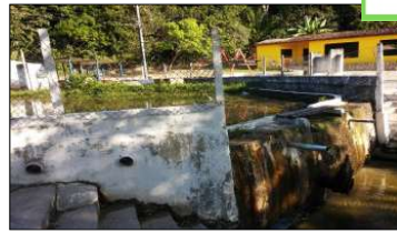
Figura 55. Barragem do Riacho Aviação. Fonte: MJ Engenharia
