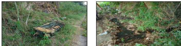
Figuras 150 e 151. Resíduos no terreno da ETE e esgoto a céu aberto oriundo de ligações clandestinas. Fonte: MJ Engenharia
