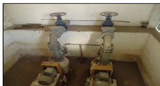
Figuras 126 e 127. Vista da Câmara de Chegada e dos GMBs da EEE – Jardim Esperança. Fonte: MJ Engenharia
