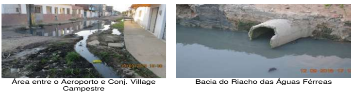
Figura 171: Presença de Resíduos Sólidos e esgotos sanitários na rede de drenagem. Fonte: Autor, setembro/2015.
