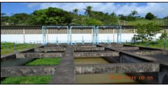
Figura 51. Entrada da captação. Fonte: MJ Engenharia
