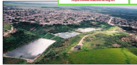
Figura 144. Vista aérea do sistema de tratamento por lagoas de estabilização de Benedito Bentes. Fonte: Maceió, IBAM, 2005
