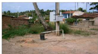
Figura 42. Poço de captação da CASAL
