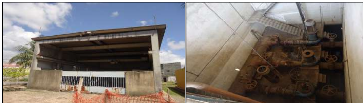
Figuras 94 e 95. Vista geral e dos GMBs da EEE Riacho Salgadinho. Fonte: MJ Engenharia
