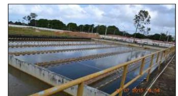
Figura 60. Decantadores. Fonte: MJ Engenharia.
