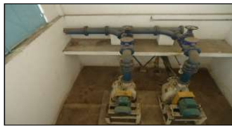
Figuras 128 e 129. Vista Geral e dos GMBs da EEE – Vergel do Lago. Fonte: MJ Engenharia
