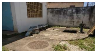
Figuras 126 e 127. Vista da Câmara de Chegada e dos GMBs da EEE – Jardim Esperança. Fonte: MJ Engenharia
