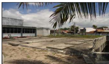
Figuras 76 e 77. Unidades de Gradeamento da ETE – Disposição Oceânica e detalhe para Gradeamentos não instalados. Fonte: MJ Engenharia
