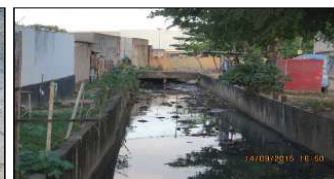
Figuras 138 e 139. Esgoto presente na rede pluvial do bairro Ponta Grossa e riacho comprometido pela poluição no bairro Vergel do Lago. Fonte: MJ Engenharia
