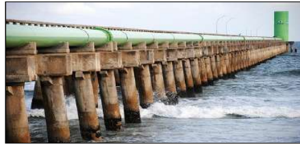
Figura 89. Emissário Submarino de Maceió – trecho de tubulação aérea. Fonte: http://www.tribunahoje.com/vgmidia/imagens/48720_ext_arquivo.jpg (acesso em 05/09/2015)
