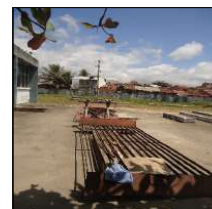
Figuras 76 e 77. Unidades de Gradeamento da ETE – Disposição Oceânica e detalhe para Gradeamentos não instalados. Fonte: MJ Engenharia
