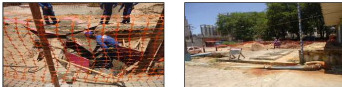
Figuras 101 e 102. Obras da Linha Expressa da Praça Lions. Fonte: MJ Engenharia
