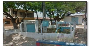
Figura 50. Poço de captação da CASAL
