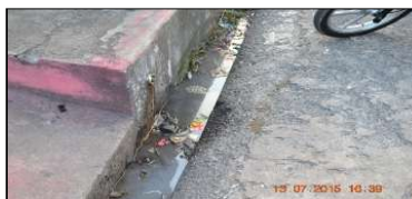
Figuras 138 e 139. Esgoto presente na rede pluvial do bairro Ponta Grossa e riacho comprometido pela poluição no bairro Vergel do Lago. Fonte: MJ Engenharia
