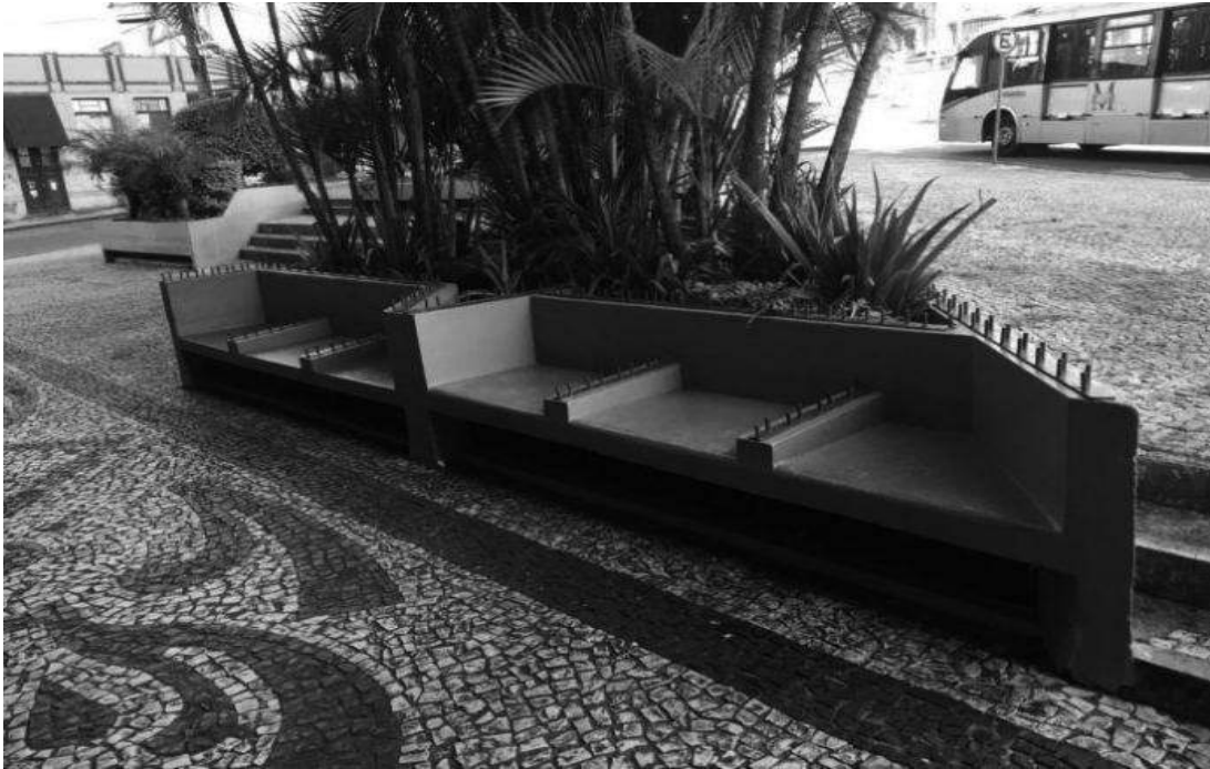
Banco com divisórias de concreto e pinos metálicos em Curitiba. Fonte: CBN Curitiba (2018). Foto de Fábio Buchmann. Disponível em: < https://cbn-curitiba.com/prefeitura-notifica-condominio-que-instalou-pinos-de-aco-em-banco-de-concreto/ >. Acesso em: 03 out. 2019.
