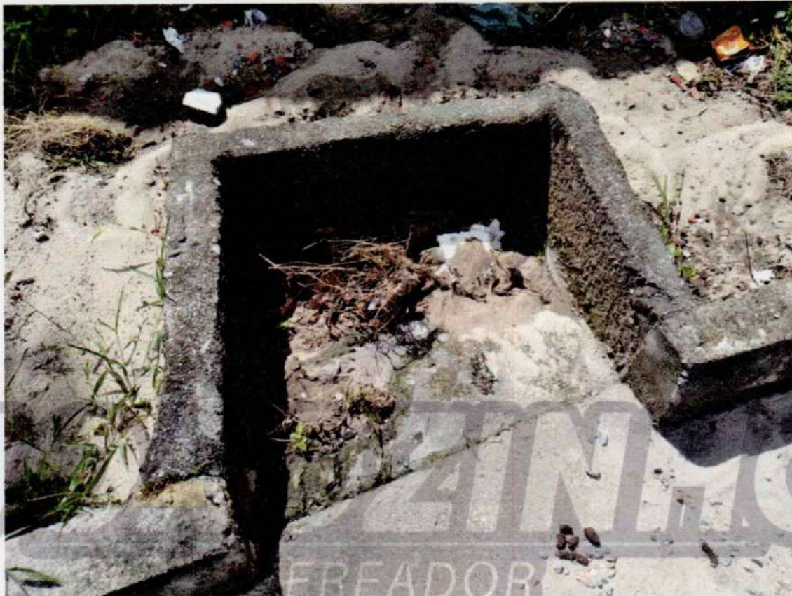
Galeria que se encontra obstruída, motivo que aumenta o fluxo em uma outra galeria próxima.
