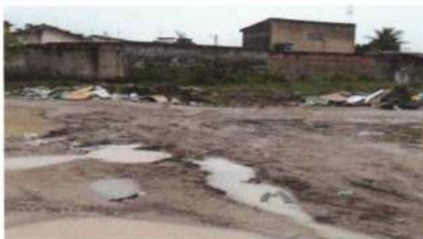
Imagens do local carente de pavimentação.
