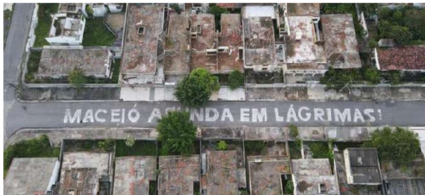
Mais de 60 mil pessoas tiveram que desocupar residências e deixar empresas para trás por causa do afundamento em Maceió - Foto: Edilson Omena
