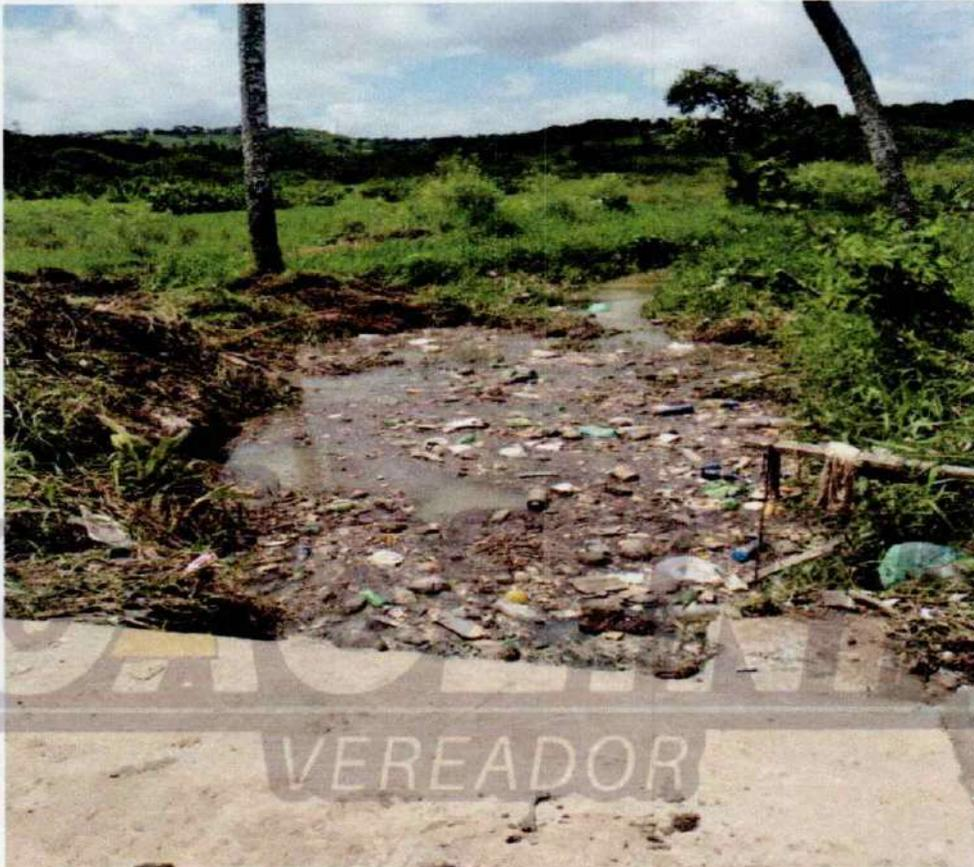
**Imagem da sujeira acumulada devido às fortes chuvas. Canal necessita de uma limpeza em toda sua extensão, a fim de desassorear e aumentar sua largura.**
