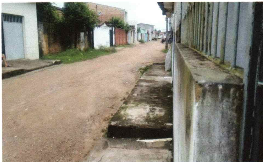
Rua da Qd 84 sem pavimentação.
