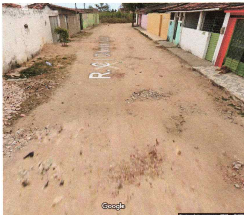
Rua da Qd 84 sem pavimentação.
