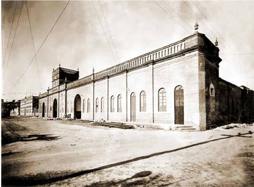
Sede da CATU, onde foi construído o Restaurante Universitário da Ufal
