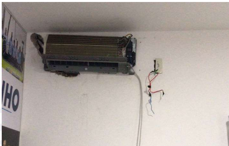
FOTO: INSTALAÇÃO DE AR-CONDICIONADO NOVO DE MARCA ELGIN
