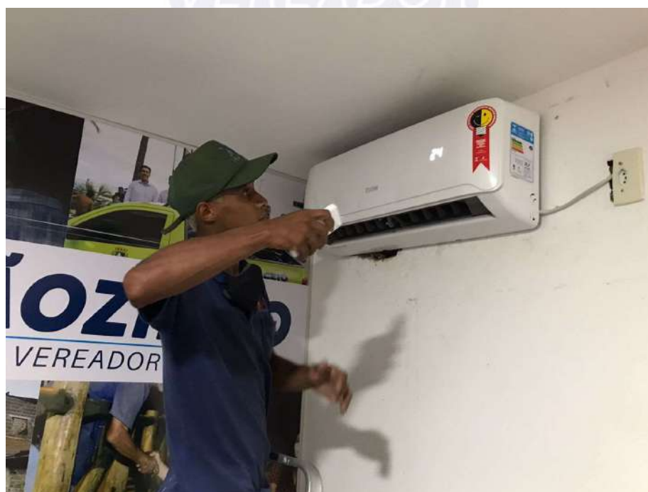
FOTO: INSTALAÇÃO DE AR-CONDICIONADO NOVO DE MARCA ELGIN
