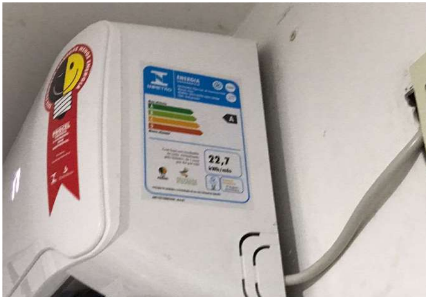
FOTO: INSTALAÇÃO DE AR-CONDICIONADO NOVO DE MARCA ELGIN
