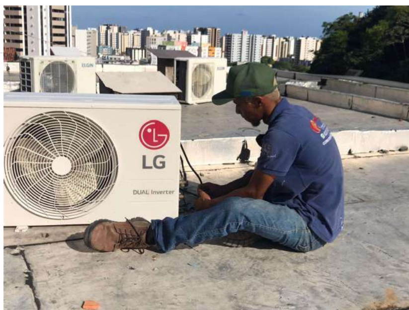
FOTO: REMOÇÃO DE AR-CONDICIONADO LG DANIFICADO
