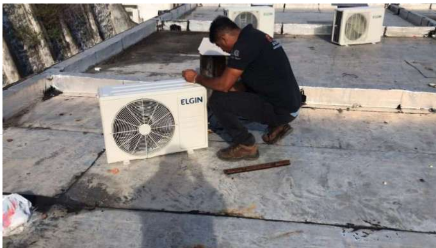
FOTO: INSTALAÇÃO DE AR-CONDICIONADO NOVO DE MARCA ELGIN
