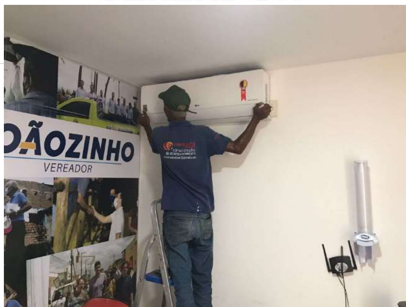
FOTO: REMOÇÃO DE AR-CONDICIONADO LG DANIFICADO
