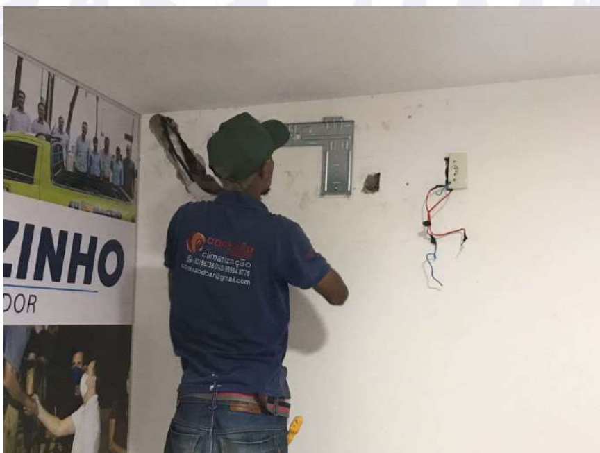
FOTO: INSTALAÇÃO DE AR-CONDICIONADO NOVO DE MARCA ELGIN
