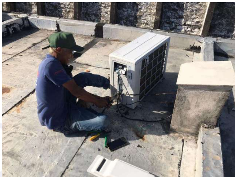
FOTO: REMOÇÃO DE AR-CONDICIONADO LG DANIFICADO
