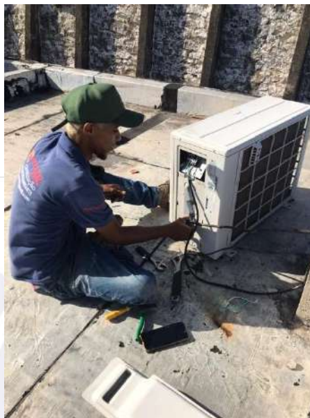
FOTO: REMOÇÃO DE AR-CONDICIONADO LG DANIFICADO
