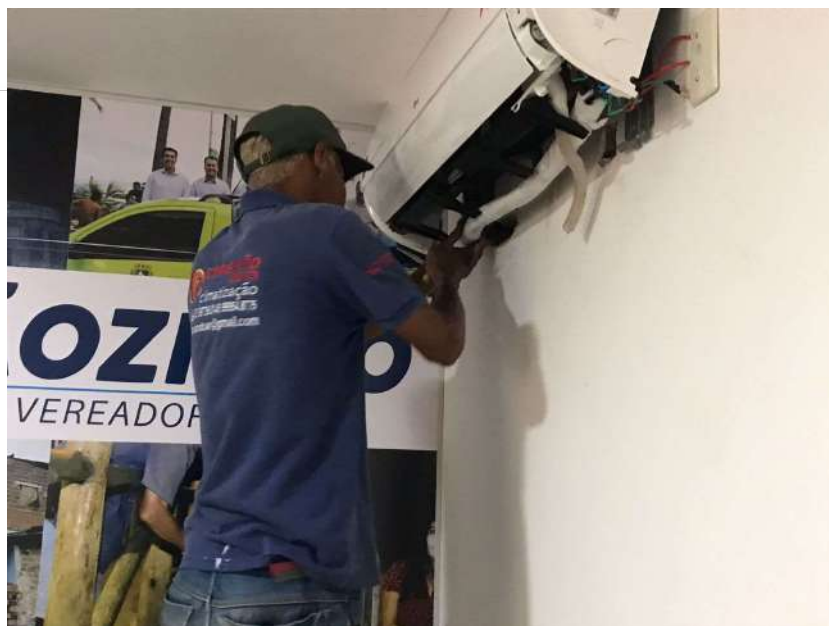
FOTO: REMOÇÃO DE AR-CONDICIONADO LG DANIFICADO
