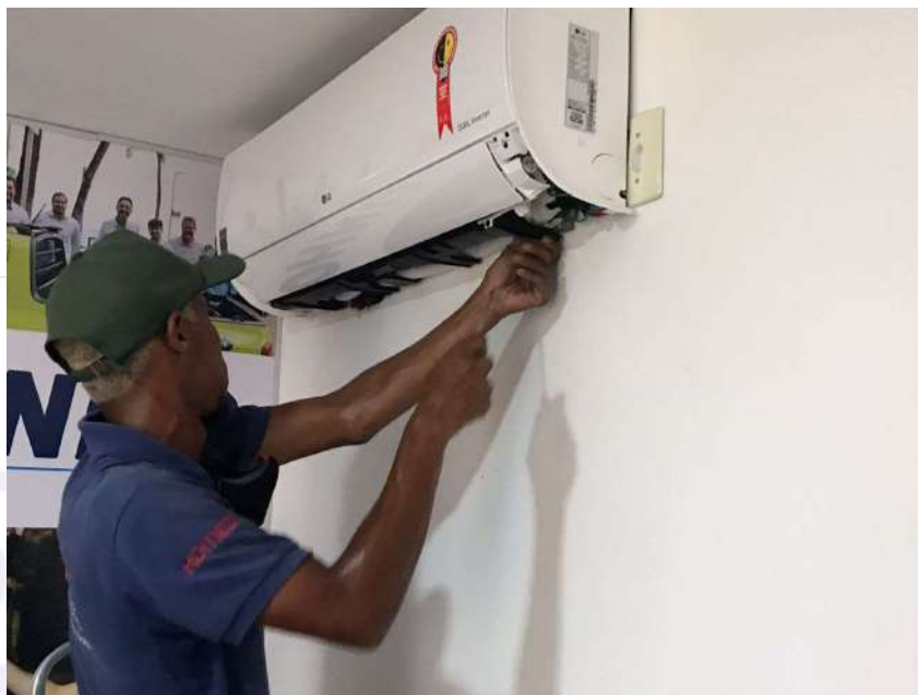
FOTO: REMOÇÃO DE AR-CONDICIONADO LG DANIFICADO
