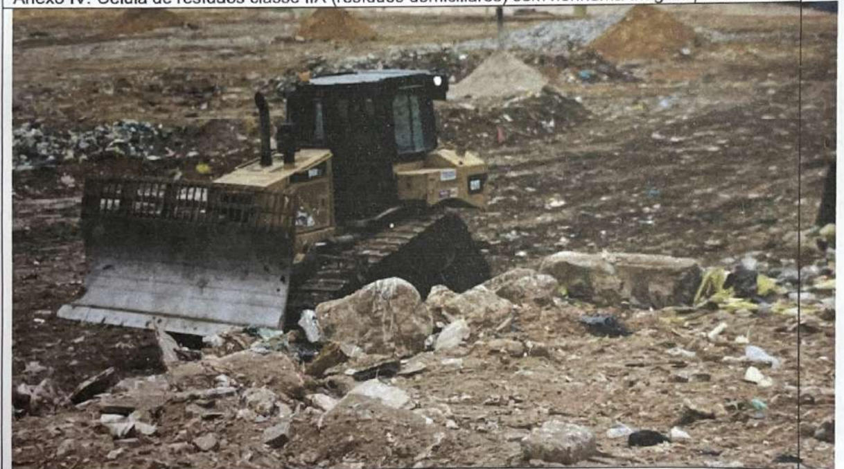
Anexo V: Célula de resíduos classe IIA (resíduos domiciliares) sem nenhuma triagem preliminar.
