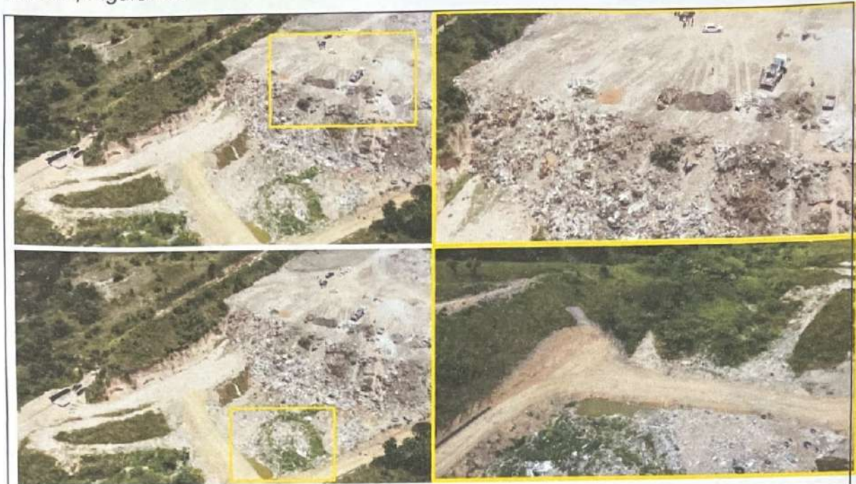
Figura 13: Célula destinada aos resíduos de classe IIB (inertes), funcionando praticamente como outra célula de classe IIA (resíduos domésticos), inclusive com acúmulo de percolato na parte inferior.
