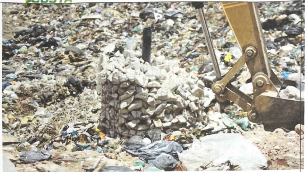
Figura 5: Péssimas condições dos drenos de gases e aparência de lixão a céu aberto.
