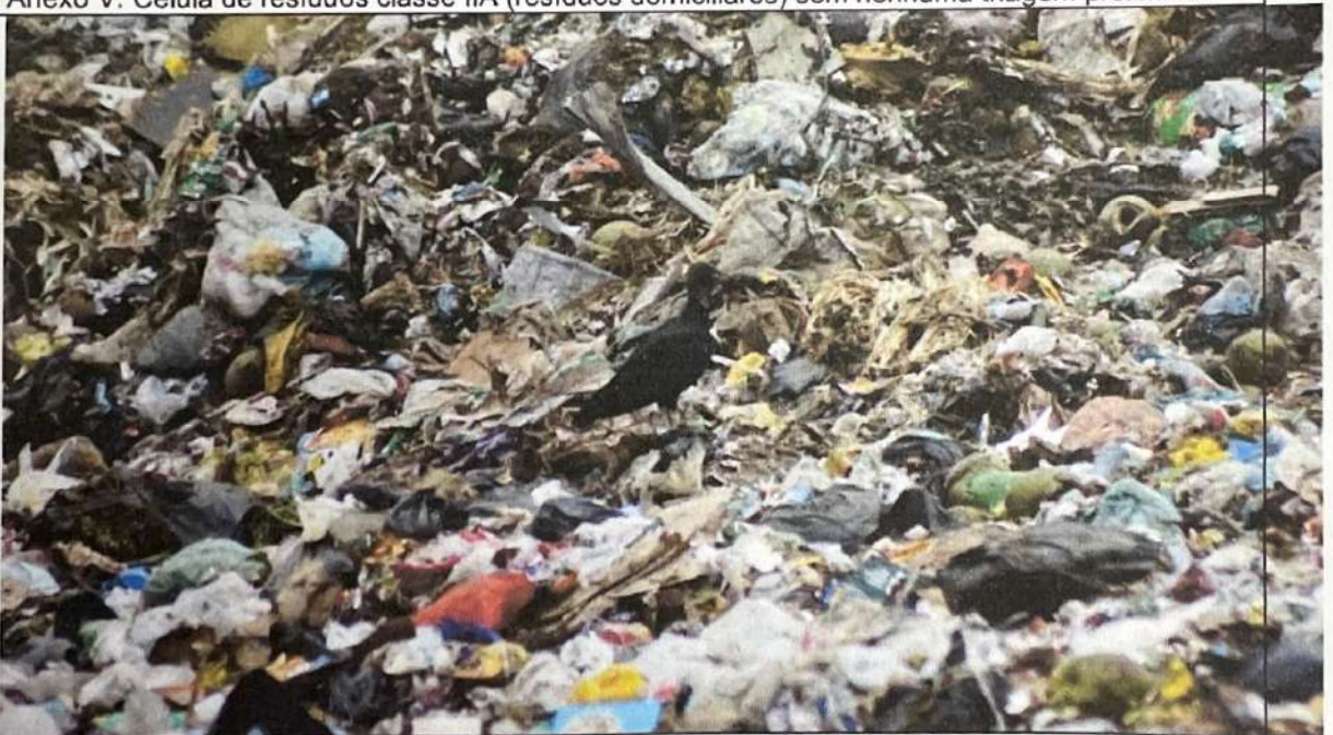
Anexo VI: Célula de resíduos classe IIA (resíduos domiciliares) com a presença constante de vetores.
